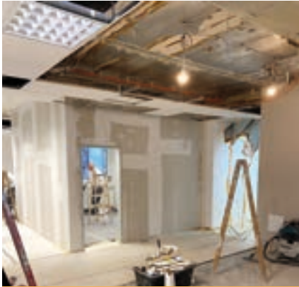
Blick in die Baustelle: Es wurden Zwischenwände gezogen, gespachtelt und Leitungen verlegt
