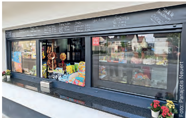
Der renovierte Kiosk
