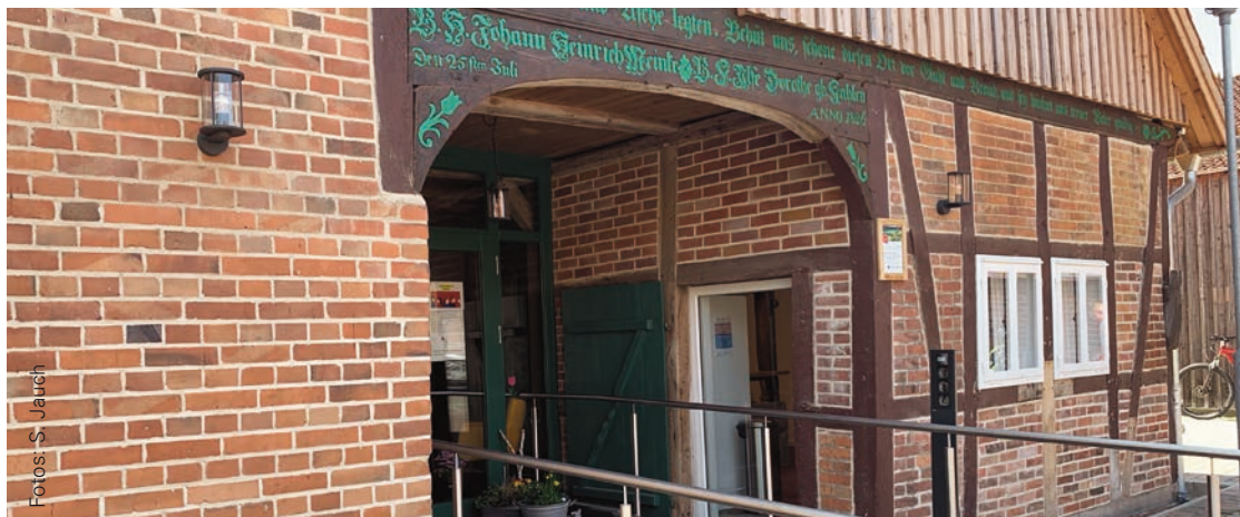
Tagespflege in restaurierter Scheune im Dorf Wahrenholz
